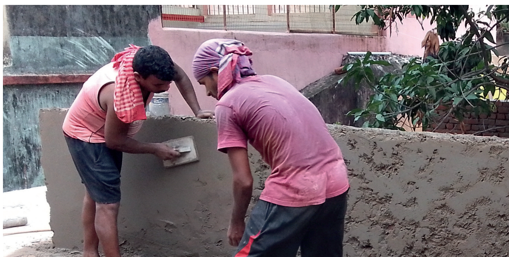
Die letzten Mauerarbeiten an die neue Schule. Foto: CRK
