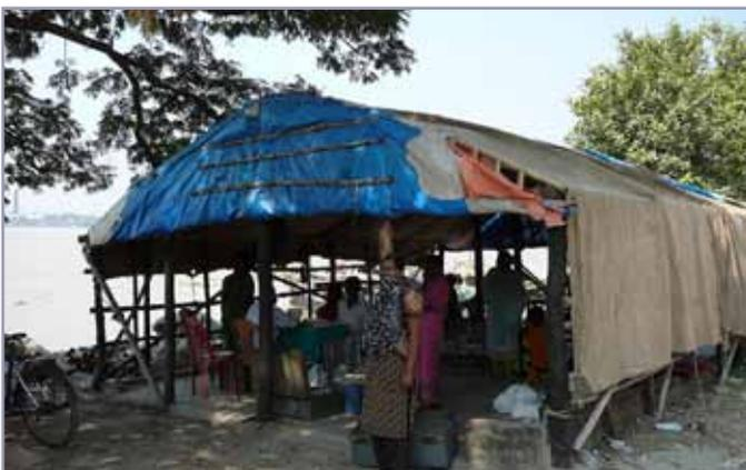
*Die bisherige Bambus-Konstruktion mit Dachplane, die täglich auf- und abgebaut wurde.*
