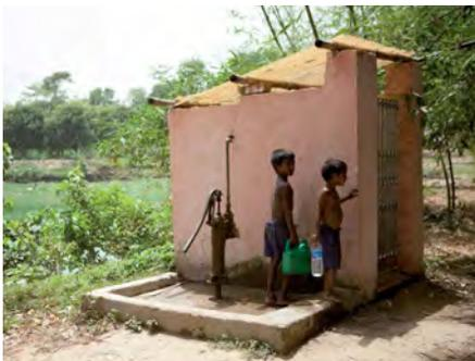
Calcutta Rescue hat die Wasserfilter, die in sechs Dörfern im westbengalischen Distrikt Malda installiert sind, mit elektrischen Pumpen versehen. Diese Massnahme hat den Dorfbewohnern sehr geholfen, da sie nun die Handpumpe nicht mehr benutzen müssen. Dadurch ist die Wassernutzung wesentlich angestiegen.
