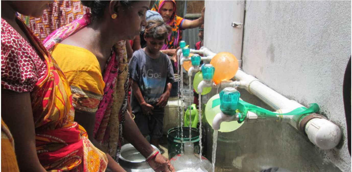
Neue Wasserleitung in Dakshineswar. Bild: CRK
