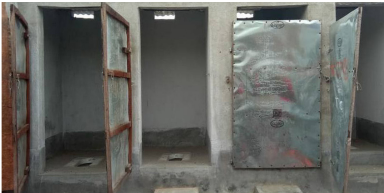
Neue Toiletten-Anlagen für Dakshineswar. Bild: CRK
